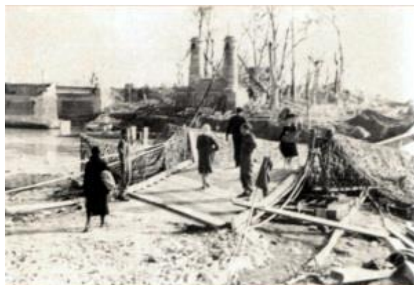
Il ponte distrutto
